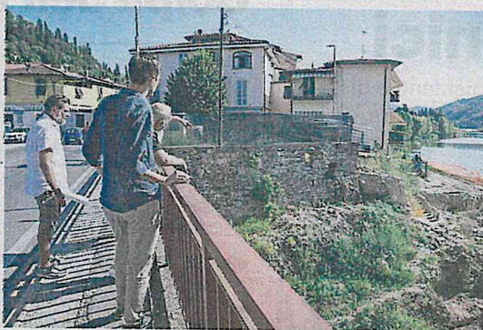
La passerella interessata dall'intervento, ad oggi i lavori sono ancora fermi
