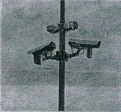
Lo speedvelox installato a Compiobbi: qui sono state rilevate oltre 100 violazioni del limite di velocità in appena 24 ore
