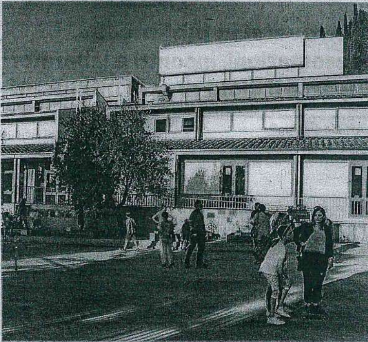
La Luigi Casini di Pian del Mugnone dove si è guastato il riscaldamento
