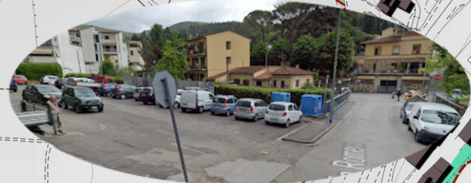
Parcheggio via Romana: - Assenza scivoli di raccordo con la carreggiata - Passaggio ridotto per la presenza di manufatti (lampione e palina della segnaletica verticale)
