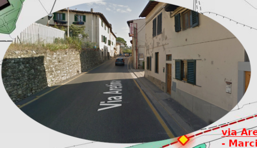
Attraversamento sulla provinciale: - Assenza di scivoli di raccordo con la carreggiata stradale - Passaggi ridotti per la presenza di manufatti (cassonetti e paline di cartellonistica verticale) - Marciapiedi di larghezza insufficiente - Attraversamento pedonale non accessibile per persone con deficit visivo
