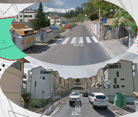
Accesso Piazza Etrusca - Marciapiedi di larghezza insufficiente - Passaggi ridotti per la presenza di manufatti (segnaletica verticale, lampioni cassonetti) - Assenza di scivoli di raccordo con la carreggiata
