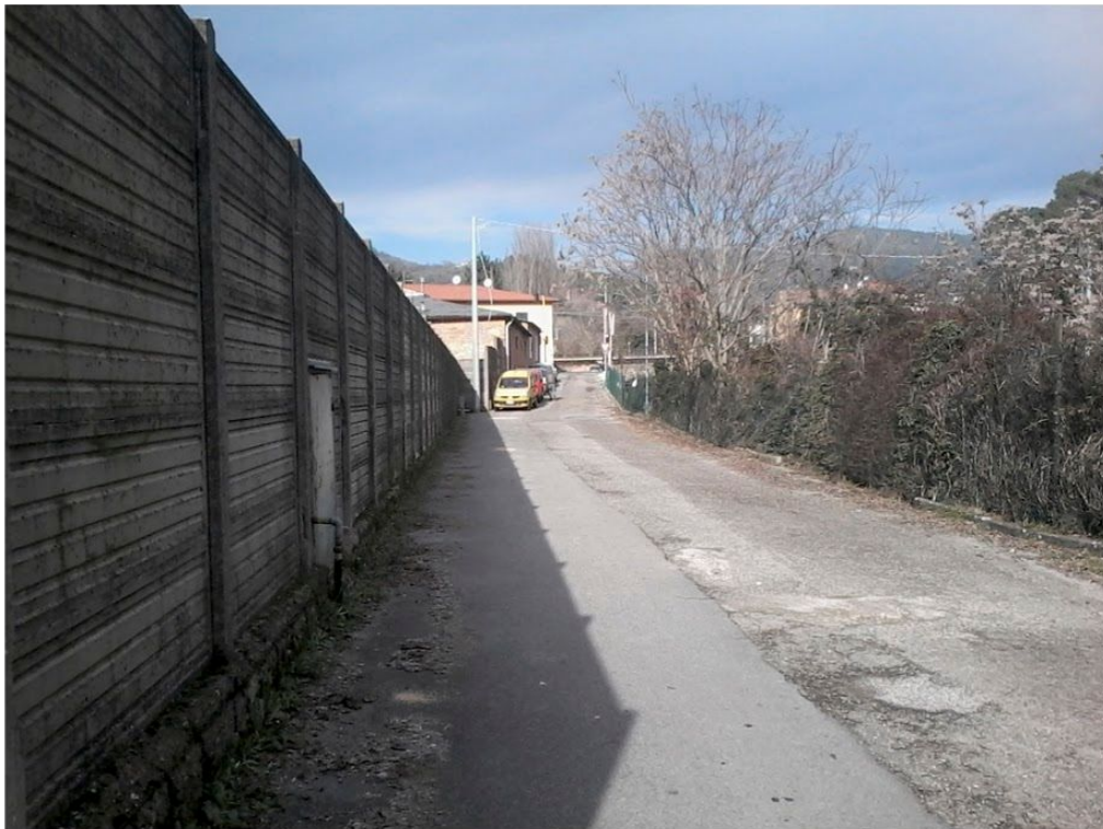
Figura 1.3 – Muro perimetrale lato fosso delle Falle.
